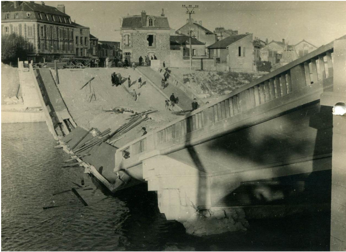
Effondrement du Pont de la Marne
